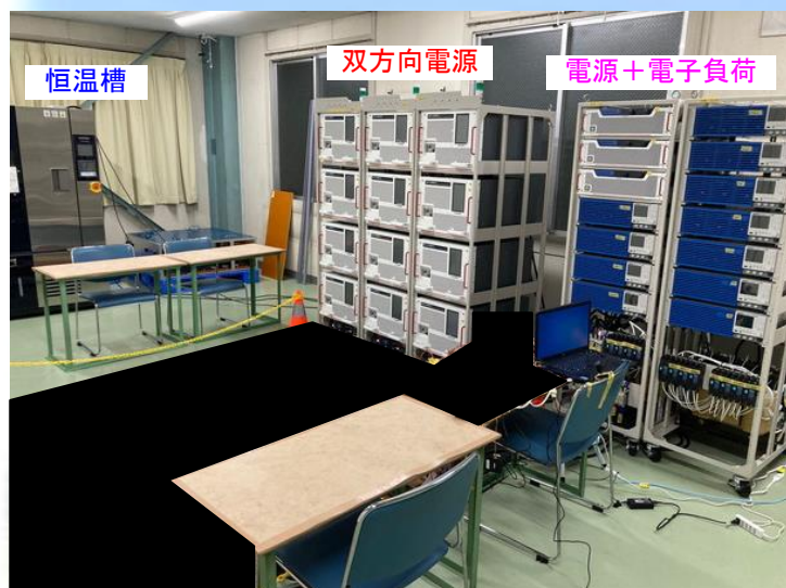
遠隔実験室設備
